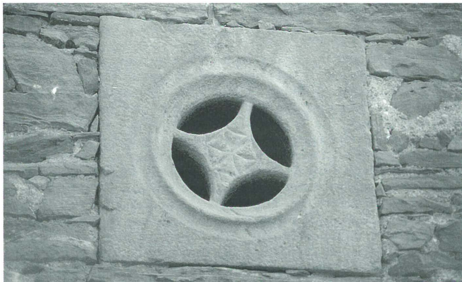
Can Boada de les Parentes. Claustra a la façana posterior.
