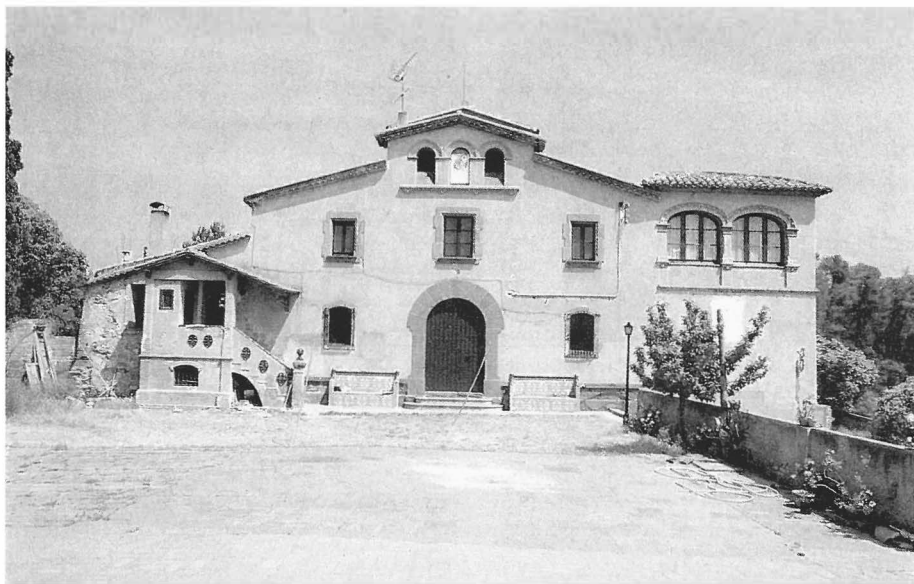
Can Sanahuja. Façana principal.
