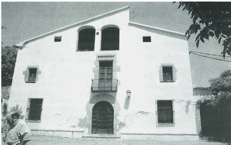
Can Cabassa. Façana principal.
