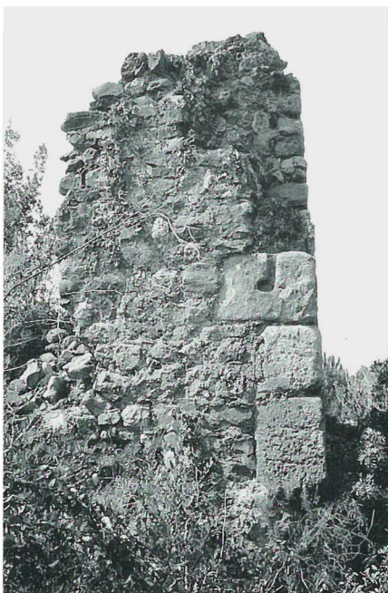
Castell de Toudell. Detall de l'estructura superior.
