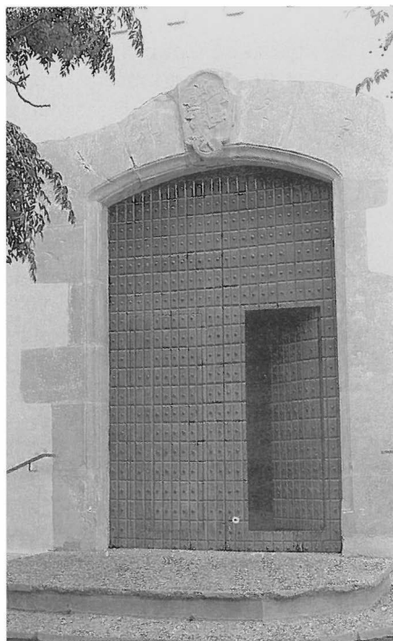
Sant Martí de Sorbet. Portal d'entrada a l'església actual.
